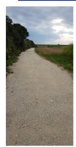
Le chemin rural qui mène à Bliesbruck n'était plus praticable que par les engins agricoles. Les agriculteurs et le conseil municipal se sont prononcés en faveur de sa réfection urgente. L'ancien chemin a dès lors été décaissé puis recouvert de concassé calcaire sur plus de 300 mètres. Les travaux ont été réalisés par l'entreprise Terrapat avec la participation de l'ouvrier communal, Stéphane Muller.
