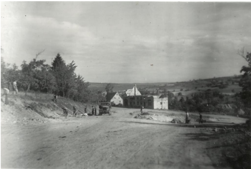
Construction de l'ilot
